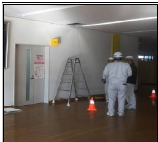
図４ 保健室 LAN 延線工事
