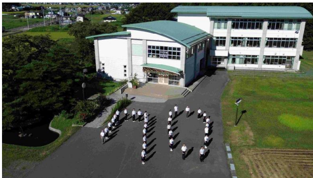
図11 ドローンで空撮した校舎全景
