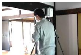
図7 屋内レーザー測量
