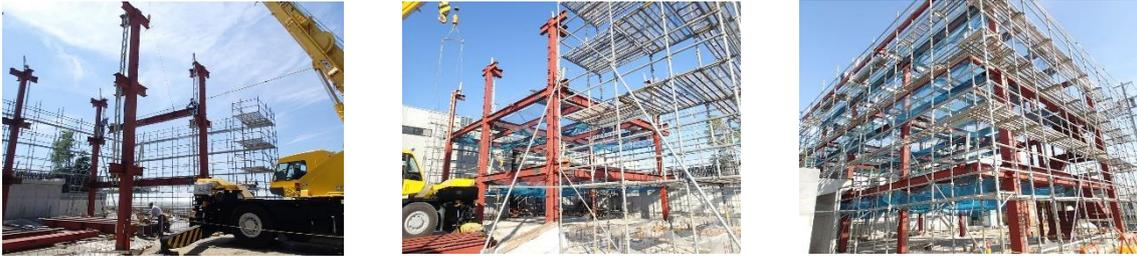
図3－鉄骨建て方：一連の工程を動画として流す
