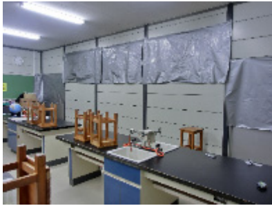
図 窓枠への取り付け
